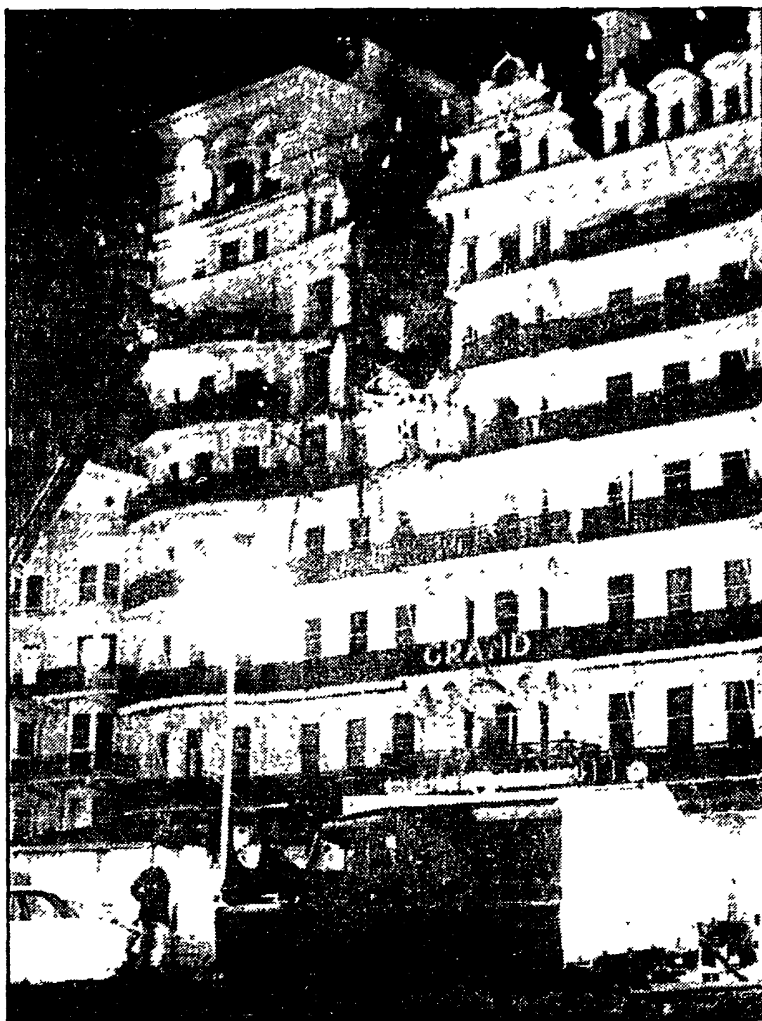
BRIGHTON — La facciata del Grand Hotel, con l'enorme squarcio provocato dall'esplosione
