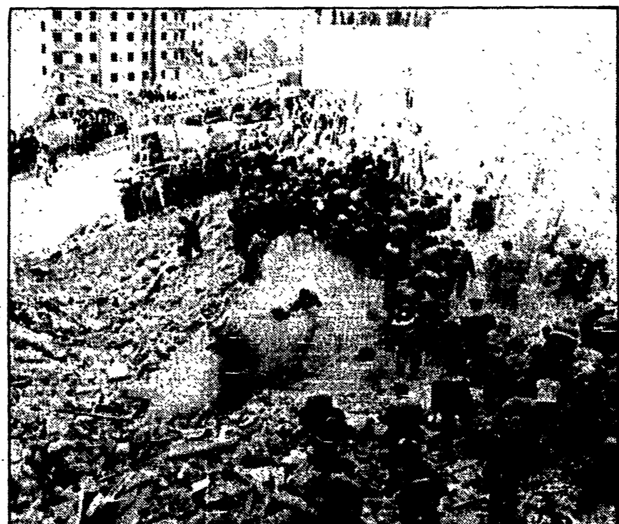
CASTELLANETA. Per tutta la giornata si è scavato tra le macerie del palazzo crollato. Sopra al titolo vigili del fuoco estraggono il corpo senza vita di un uomo.
