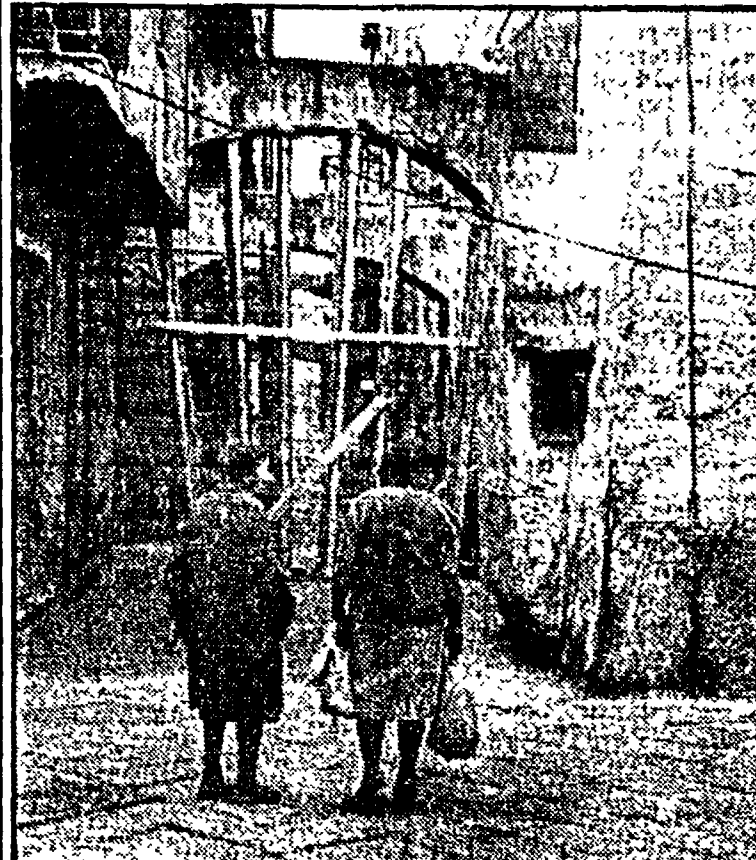
Pozzuoli, un vicolo del centro storico, vicino al porto, puntellato. Ora si discute del piano di recupero
