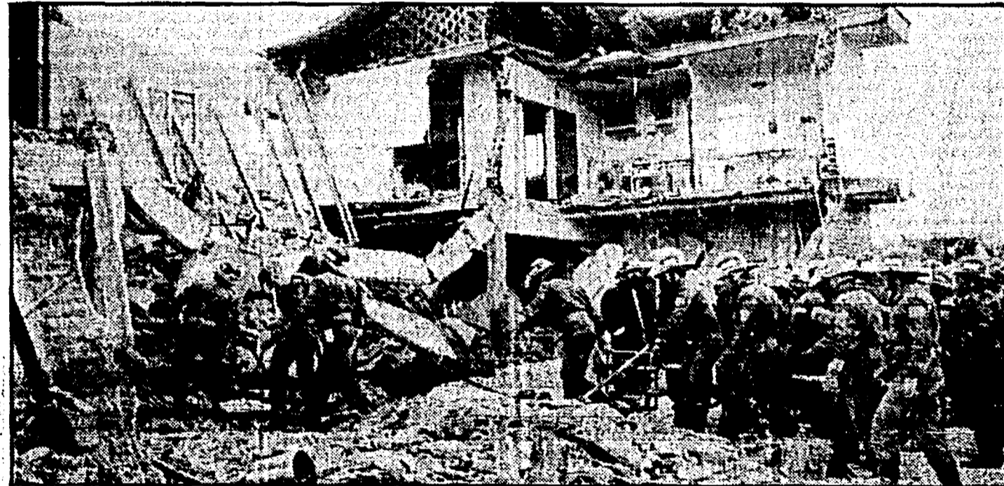
MADRID - Squadre di soccorso tra le macerie del ristorante completamente distrutto dalla violenta esplosione
