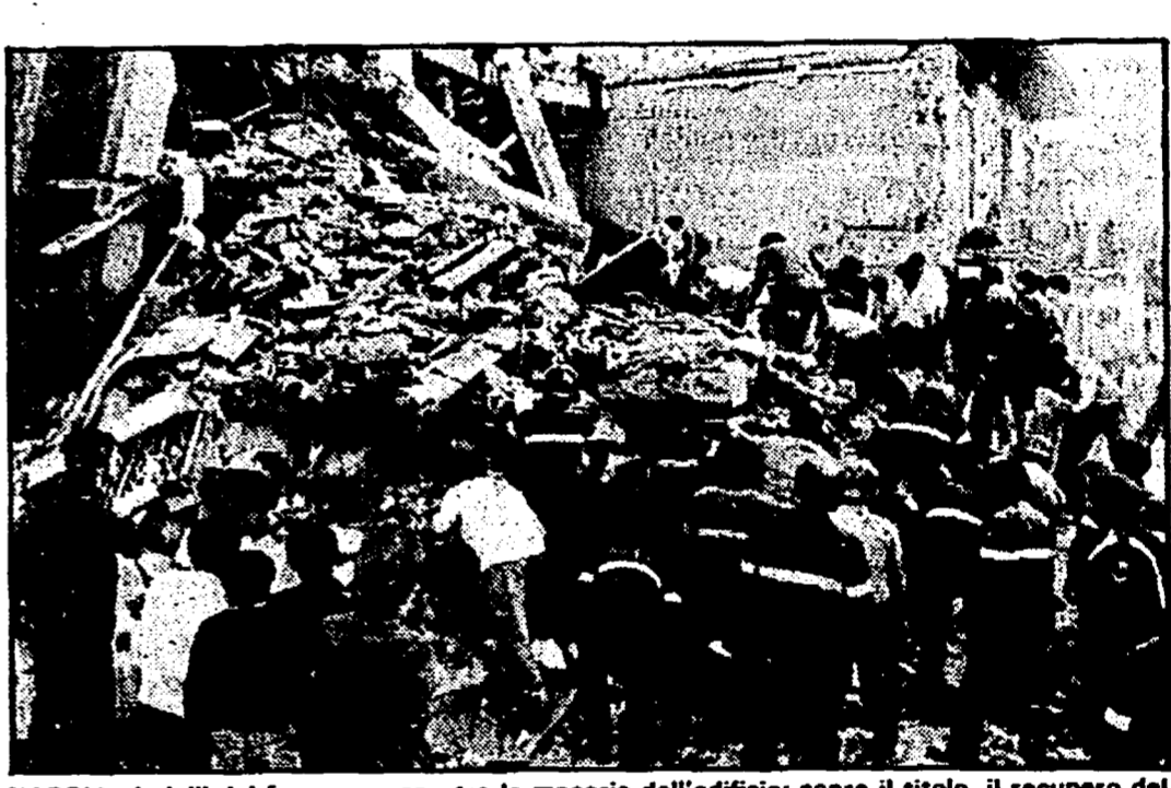
NAPOLI - I vigili del fuoco scavano tra le macerie dell'edificio; sopra il titolo, il recupero del corpo di una delle vittime
