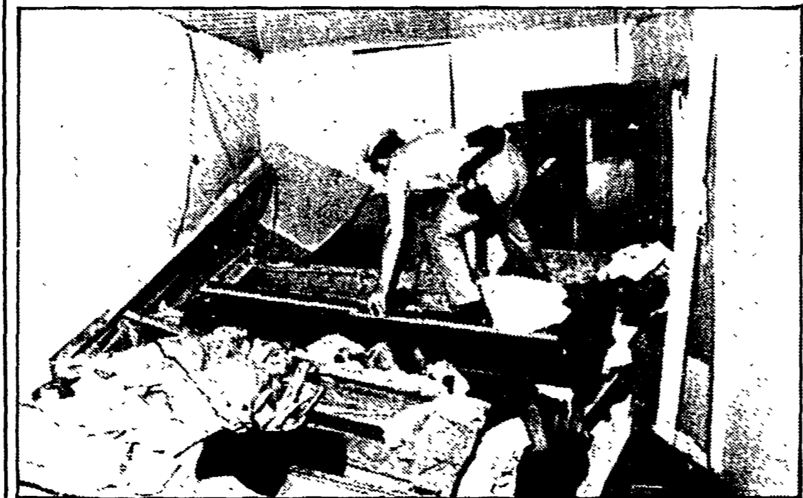
NAPOLI — L'interno del container devastato dall'esplosione
