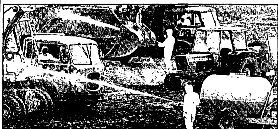
SEVESO — Operazioni di bonifica
