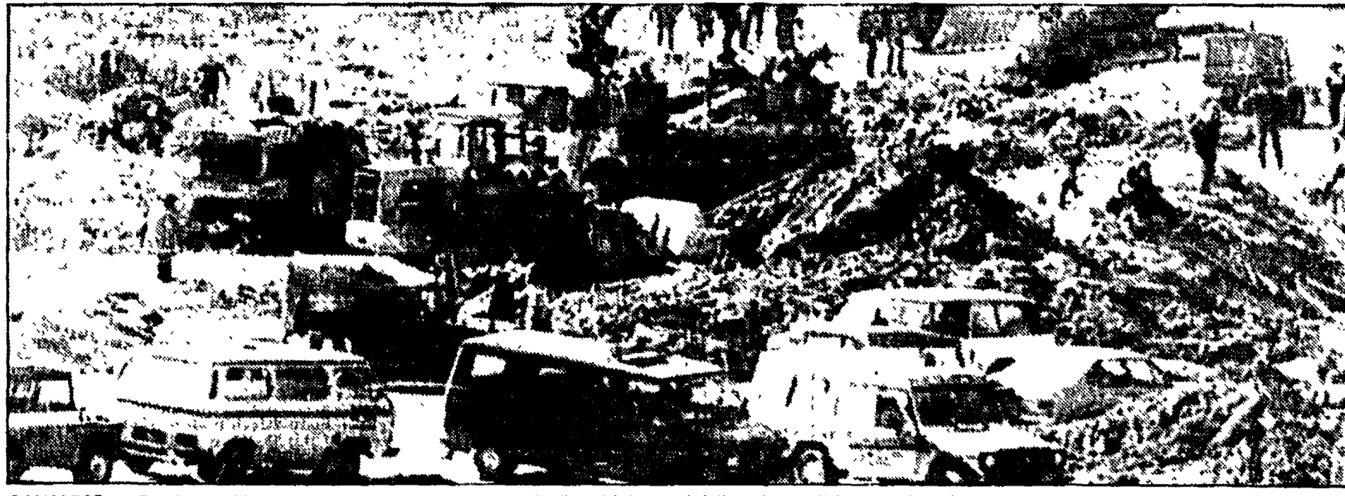
CAVALESE — Bulldozer al lavoro nel luogo dove sorgevano gli alberghi distrutti dalla valanga di fango e detriti
