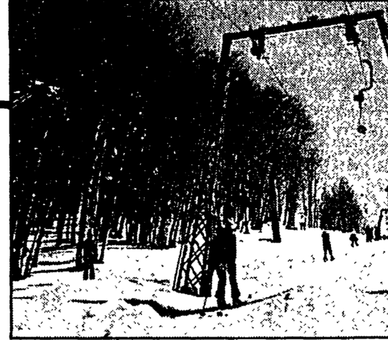
Il primo impianto nacque negli anni '30
