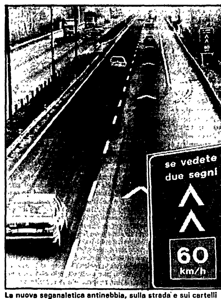
La nuova segnaletica antinebbia, sulla strada e sui cartelli
