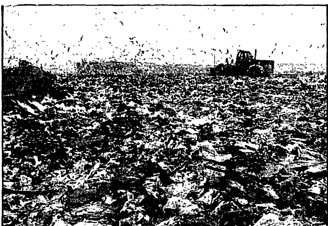
Nelle foto, sopra: la voragine di ottomila metri quadri dove viene scaricata tutta l'immondizia prima di essere avviata nella vera e propria discarica. In alto, la macchina cingolata che pressa le colline di rifiuti, circondate da nugoli di gabbiani
