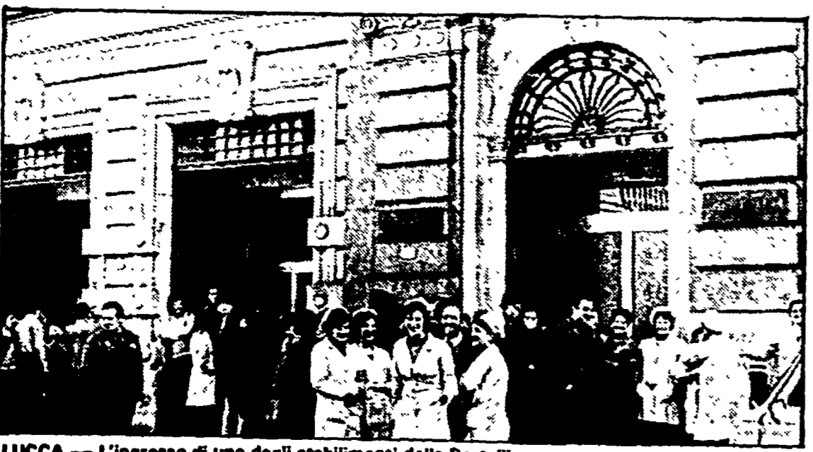
LUCCA — L'ingresso di uno degli stabilimenti della Bertoli
