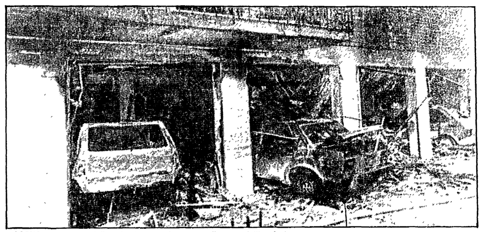
MODENA — Il garage della palazzina completamente distrutto dall'esplosione
