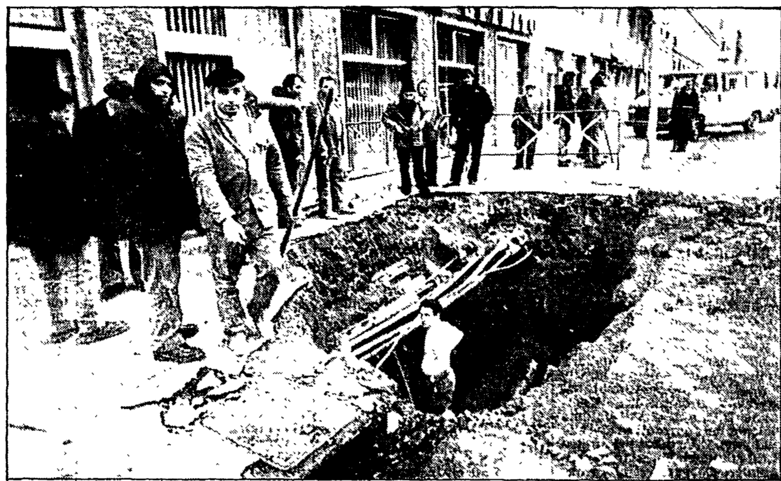
Operai al lavoro nel sottosuolo di via Ostiense e, sotto, due immagini del quartiere in estate d'assedio
