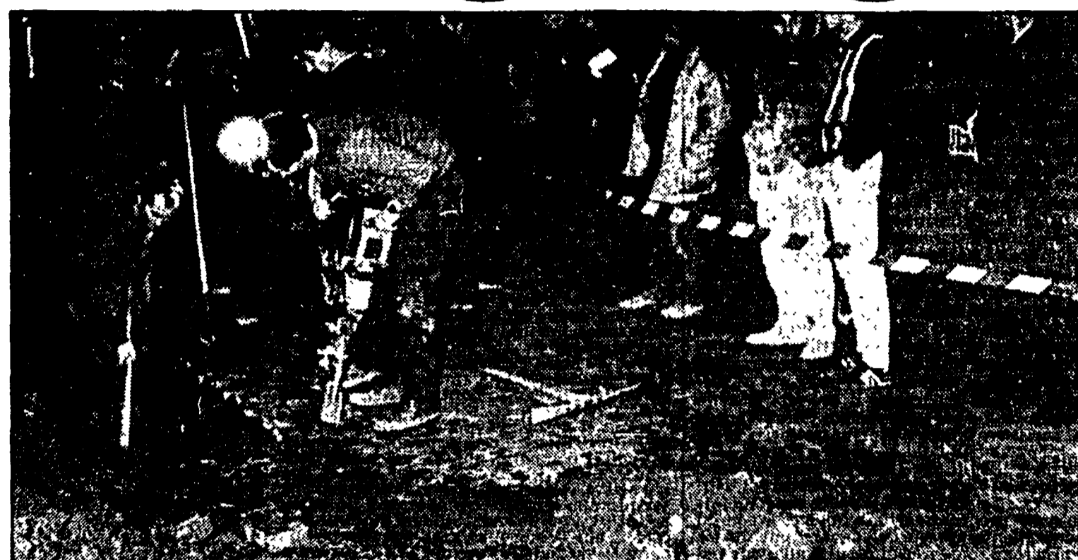
Operai dell'Italgas scavano nel punto dove è stata individuata la falla
