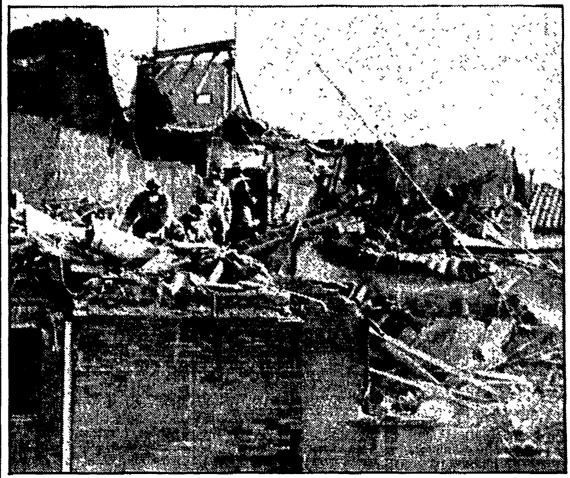
MODENA — L'edificio distrutto dall'esplosione, forse causata da una fuga di gas
