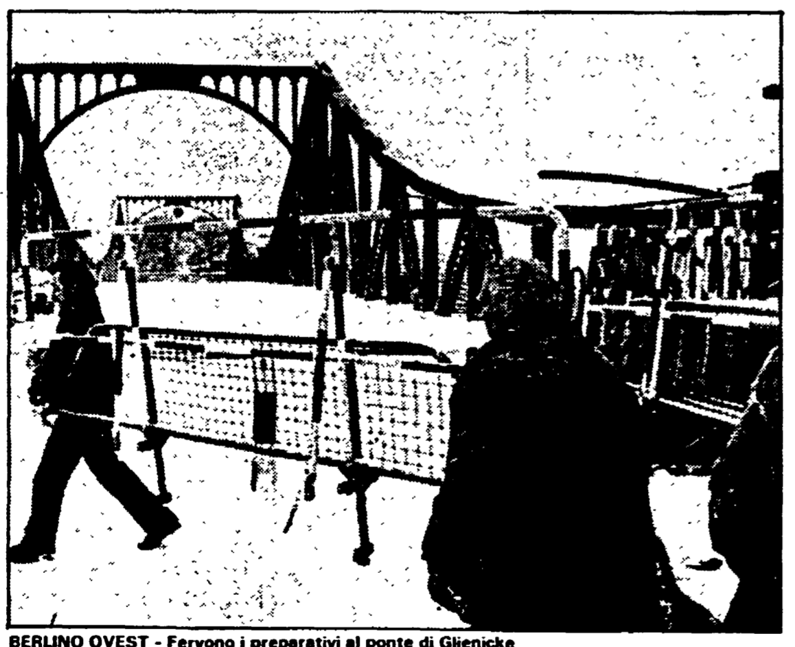
BERLINO OVEST - Fervono i preparativi al ponte di Glienicke
