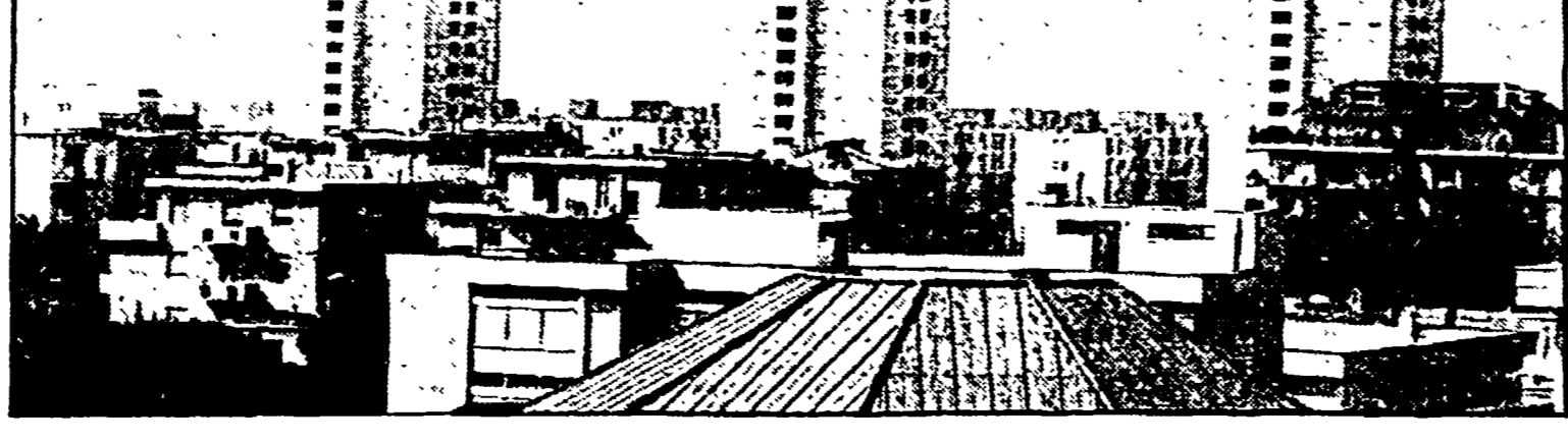
Un cantiere di edilizia a Roma
