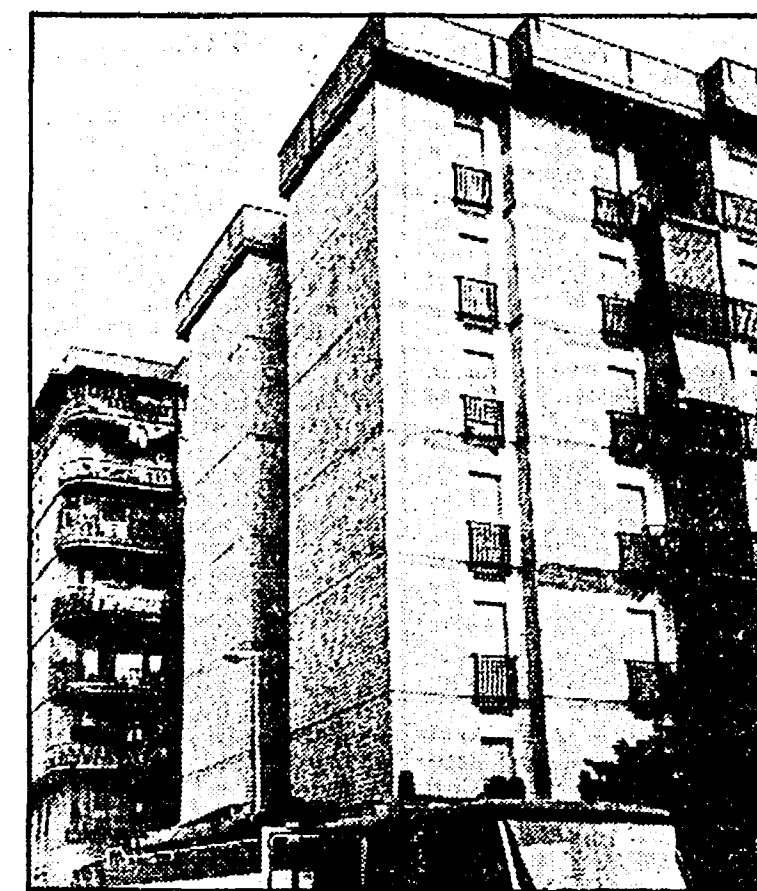
L'edificio di via Città di Prato dal quale si è staccato il cornicione
