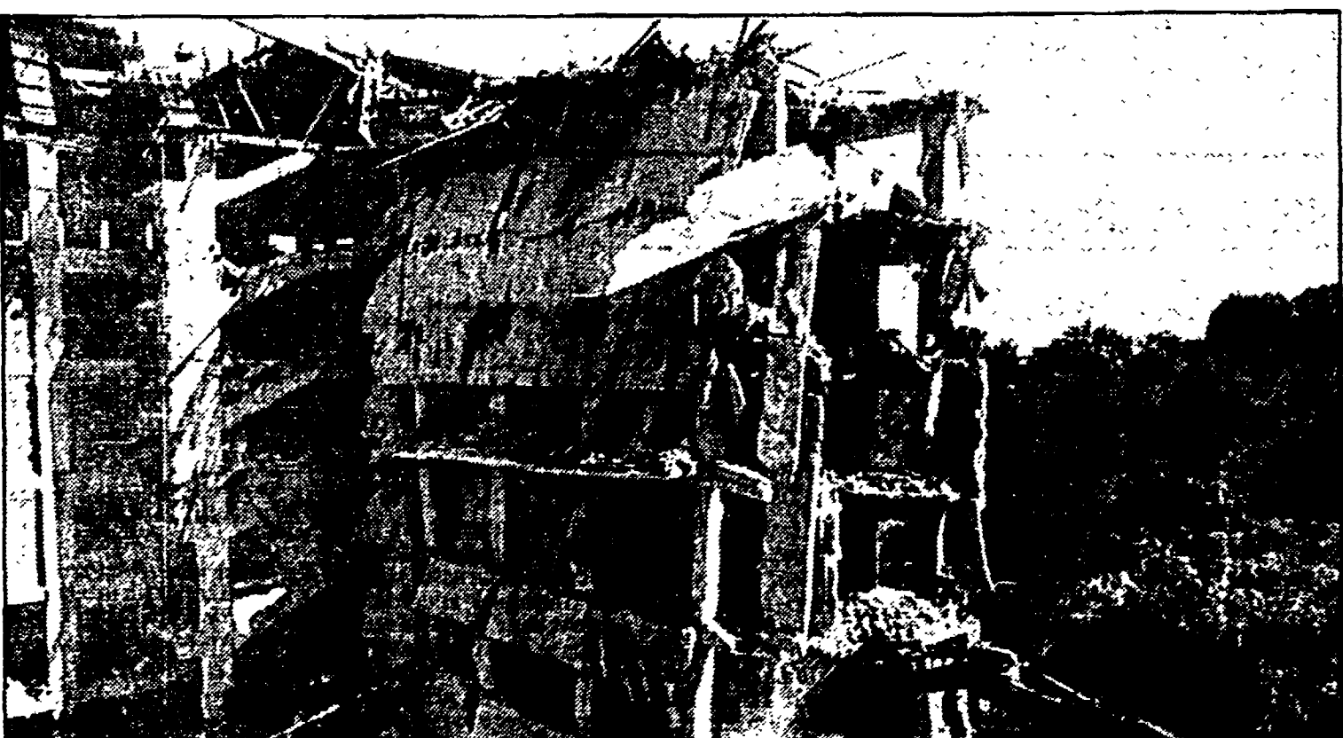
Mentre permane il caos sul condono edilizio e il governo non riesce a decidere sul da farsi, a Napoli sono stati abbattuti dai Comuni due edifici fuorilegge di sette piani ciascuno, uniti tra loro a forma di «L» per complessivi trenta appartamenti e del valore di oltre un miliardo. I palazzi erano sorti a Chiaiano, un quartiere sulla parte orientale della collina dei Carmelidi. I due edifici, sequestrati nell'85 perché costruiti in zone con vincoli paesaggistici, erano di proprietà di un prestanome di un boss camorristico della zona
