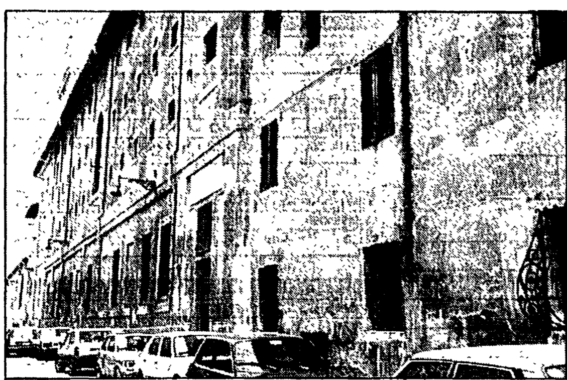
L'ingresso del San Michele dove c'è una parte dell'Istituto del restauro
