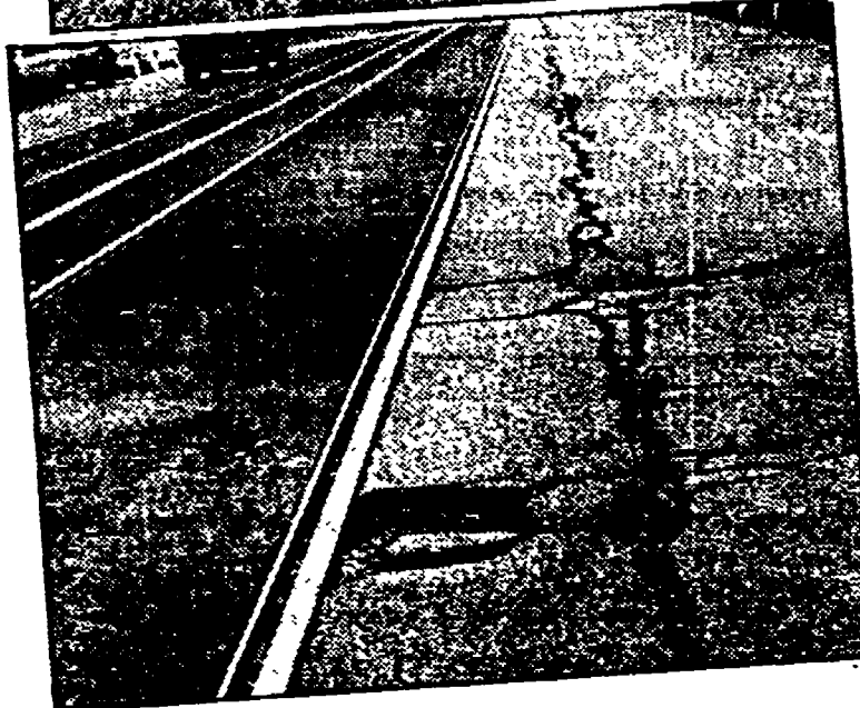
Immagine di via Cavour: il manto stradale è gravemente danneggiato sia nella parte asfaltata, sia in quella selciata. Lo scavo di numerose buche praticato dalle aziende di servizi ha reso più drammatica la situazione, e tuttavia una manutenzione straordinaria delle strade non viene fatta da più di venti anni
