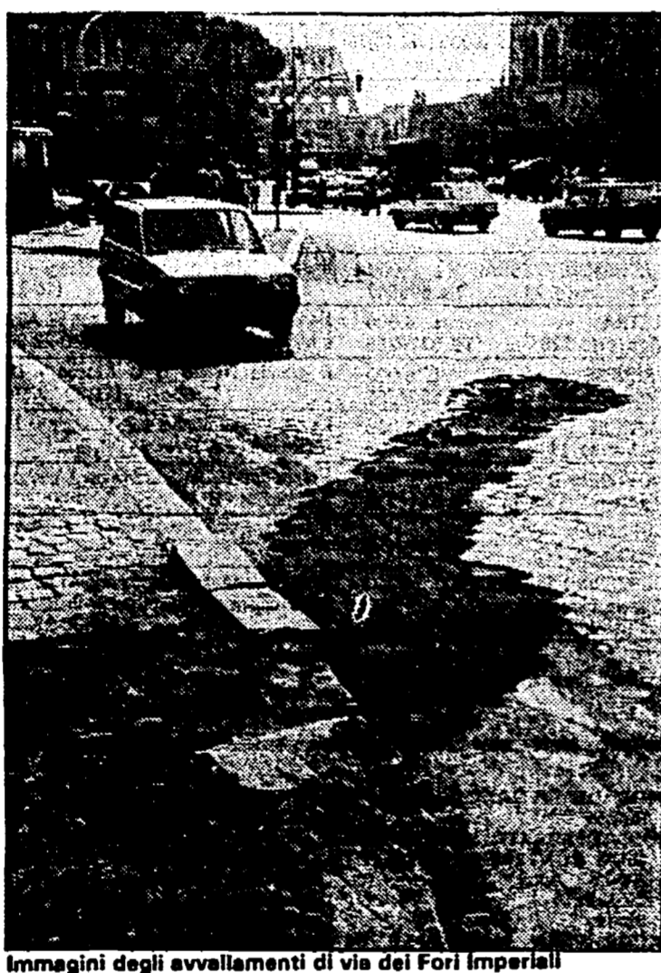
Immagini degli avvallamenti di via dei Fori Imperiali
