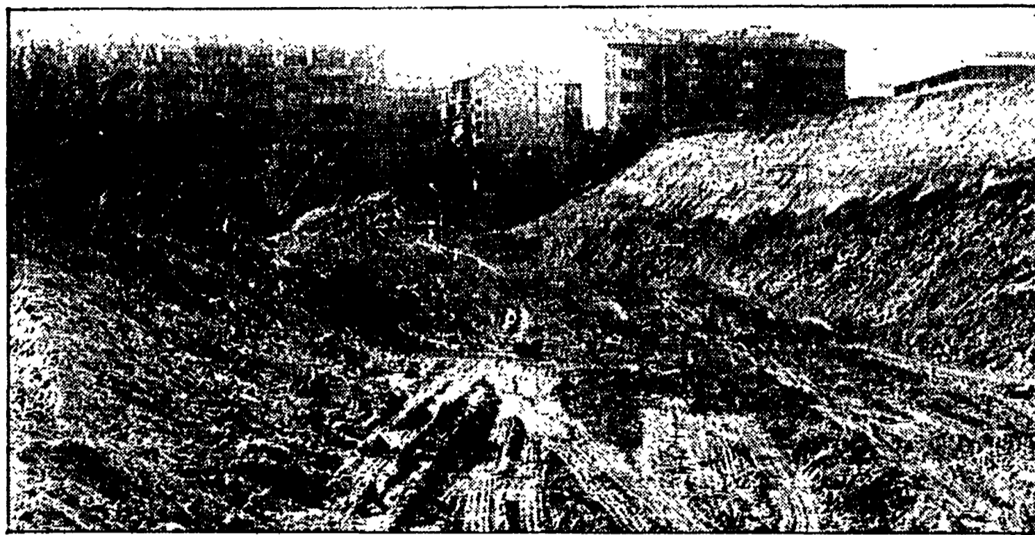
Nella foto i lavori di scavo per la prima trincea all'incrocio con via di Portonaccio. Nei disegni sopra il progetto con i due bracci che si agganciano alla Tangenziale Est, sotto il progetto per la galleria sotto via di Portonaccio
