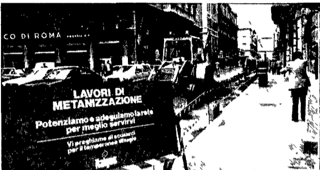
Lavori di metanizzazione in via Tomacelli
