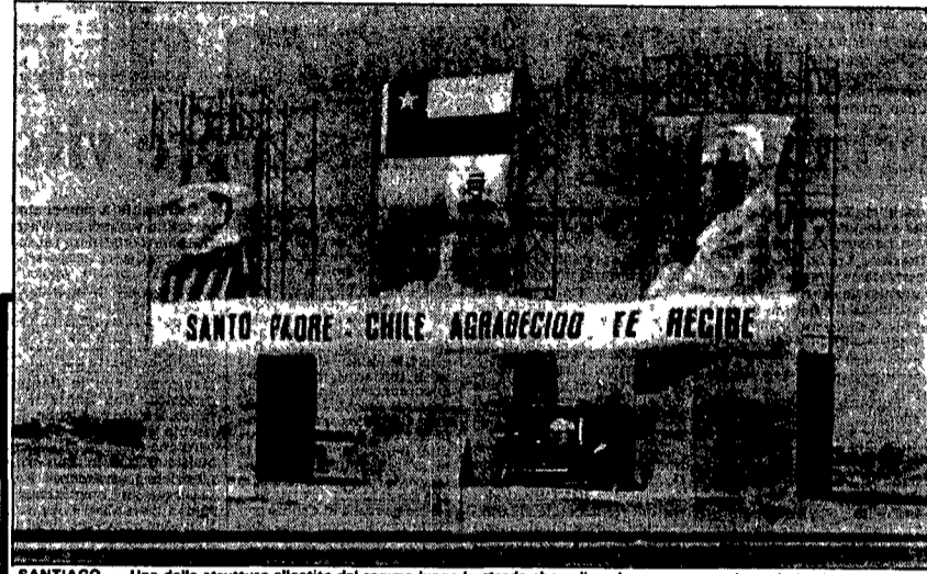
SANTIAGO — Una delle strutture allestite dal regime lungo la strada che collega l'aeroporto con la capitale cilena
