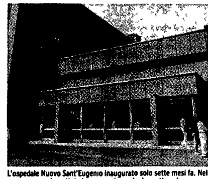
L'ospedale Nuovo Sant'Eugenio inaugurato solo sette mesi fa. Nel marzo scorso è scattata la convenzione che lo mette a disposizione di Tor Vergata
