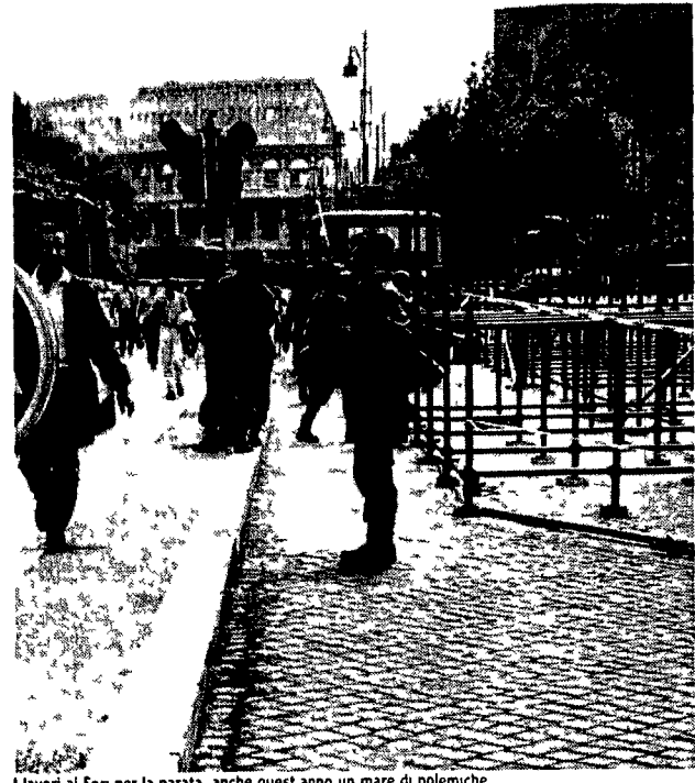
I lavori ai Fori per la parata anche quest'anno un mare di polemiche
