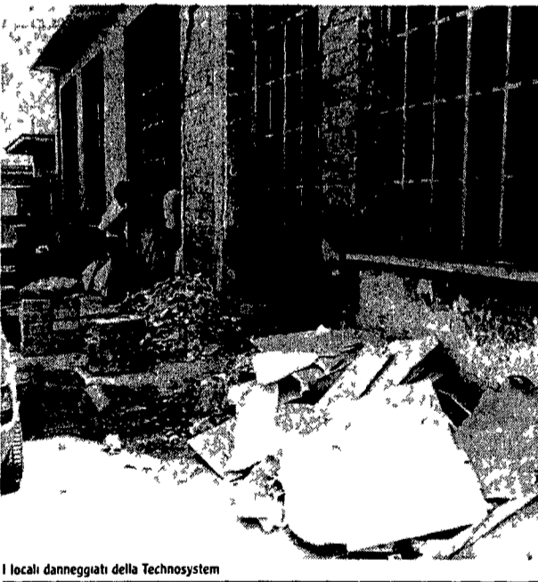
I locali danneggiati della Technosystem
