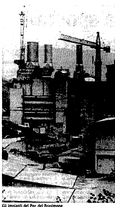
Gli impianti del Pec del Brasimone
