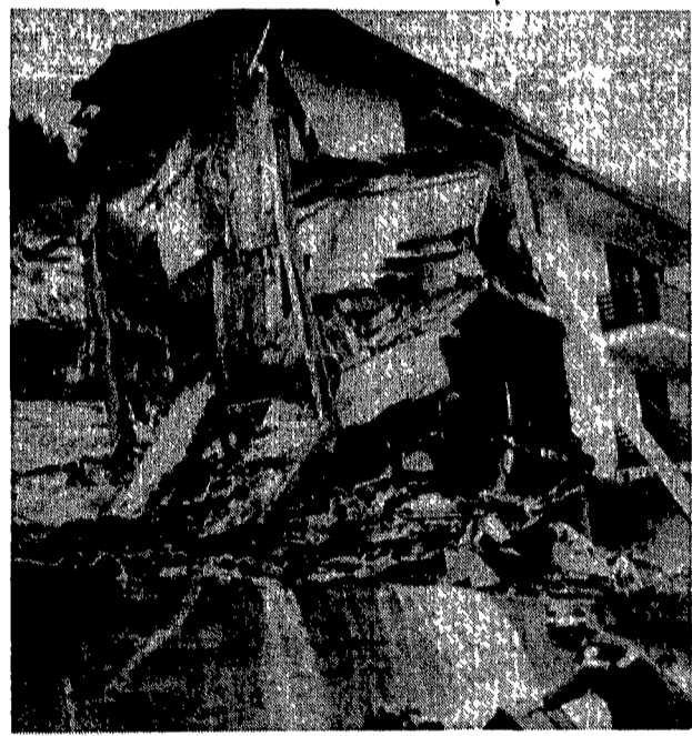
L'albergo di Tartano travolto da una frana. Dodici le vittime, ma si scava ancora
