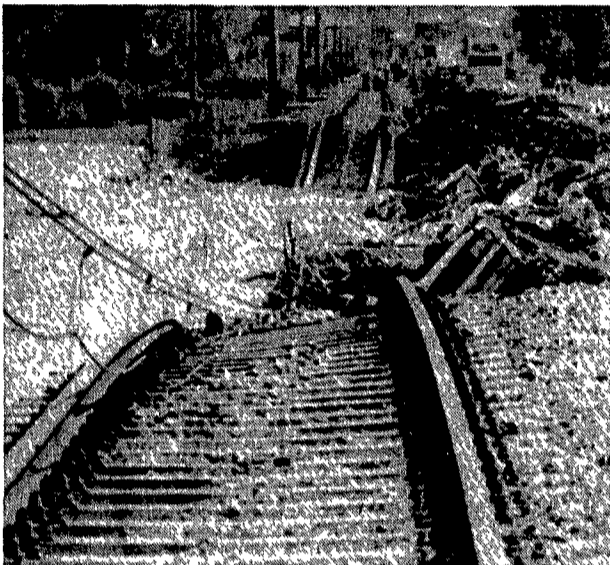
La ferrovia troncata in due dall'Adda in piena in Valtellina presso Talamona
