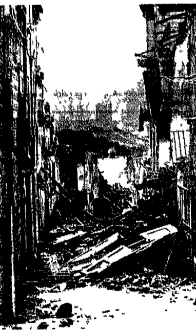
Effetto del terremoto del 1980 nel centro storico di Avellino
