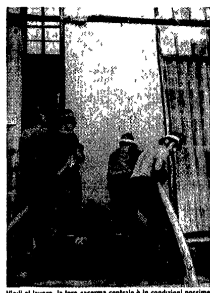
Vigili al lavoro. La loro caserma centrale è in condizioni pessime
