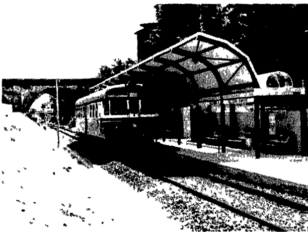
La stazione suburbana di Bologna-Rimesse. Questa nuova metropolitana, nata sulle ceneri della vecchia linea Veneta, consente un rapido collegamento tra Bologna e Portomaggiore. Alla sua realizzazione hanno contribuito l'Edilfornaciaci e la Fontana (società del gruppo Edilfornaciaci) specializzata nella costruzione e manutenzione delle linee ferroviarie. A fianco, l'intervento effettuato dall'Edilfornaciaci sul ponte sul fiume Taro: consolidamento del calcestruzzo ammalorato, sostituzione dei cavali di precompressione delle travate e sollevamento dell'impalcato
