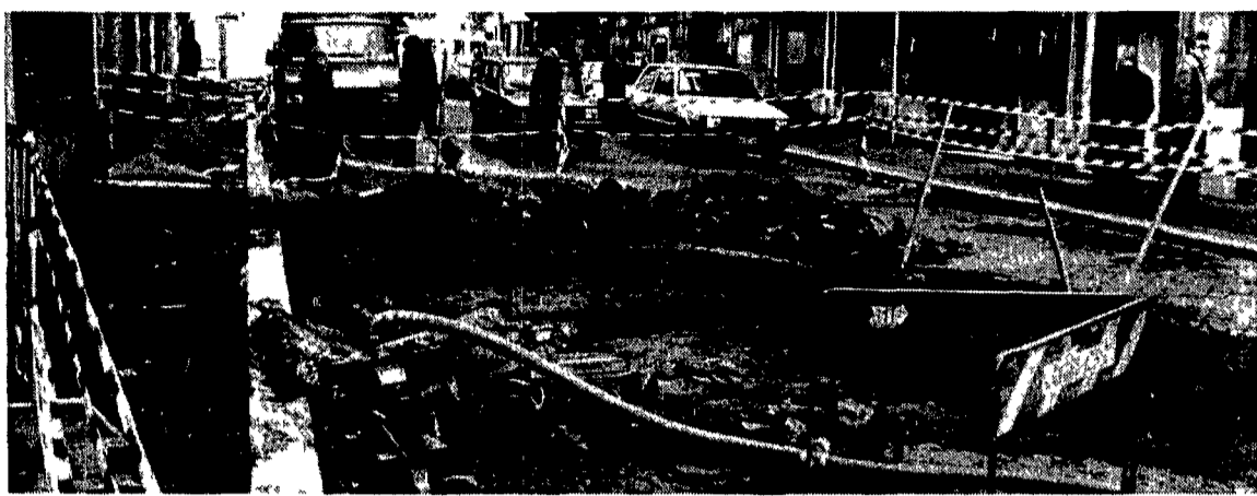
Via Sistina di nuovo sventrata. La splendida strada del centro non trova pace. Ieri così si presentava dopo lo scoppio di una conduttura dell'Accea. Secondo i tecnici dovrebbe essere ripristinata oggi.
