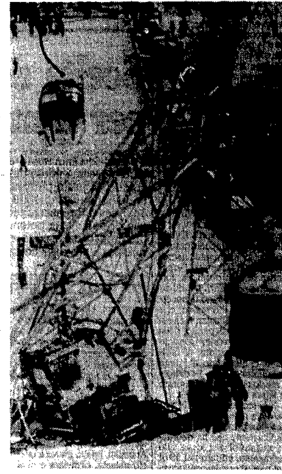
Il traliccio inclinato dopo l'urto del gatto delle nevi
