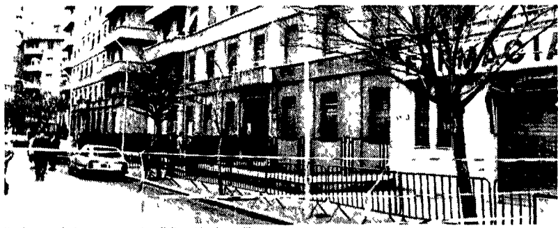
Il palazzo pericolante transennato, c'è il rischio che crolli
