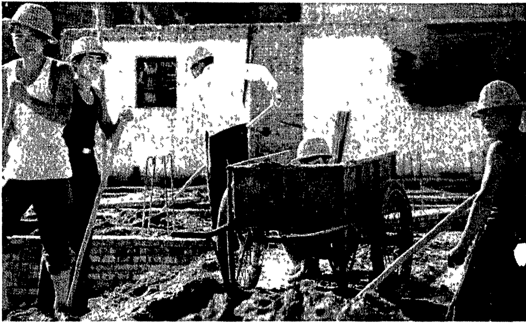
Operai edili in un cantiere di Tianjin
