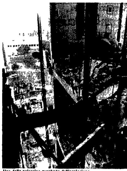
Una delle palazzine sventrate dall'esplosione
