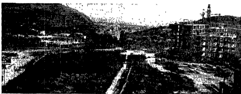
La zona ove sorge l'insediamento urbanistico di Monteruscello
