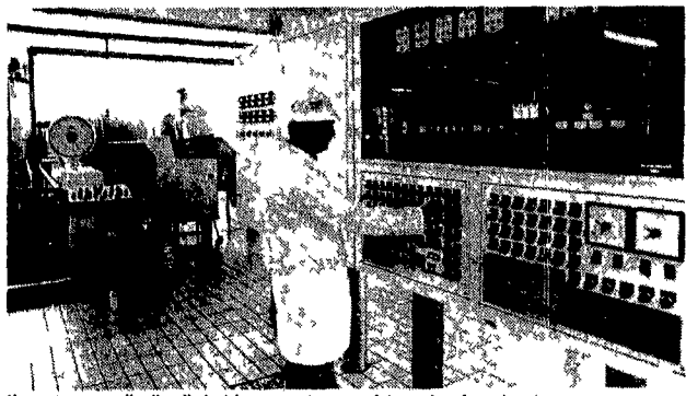
Un centro controllo di un'industria cooperativa completamente informatizzata
