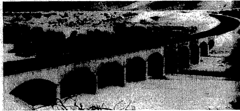
Somalia: una panoramica del viadotto che «corre» lungo la nuova strada per Bosaso
