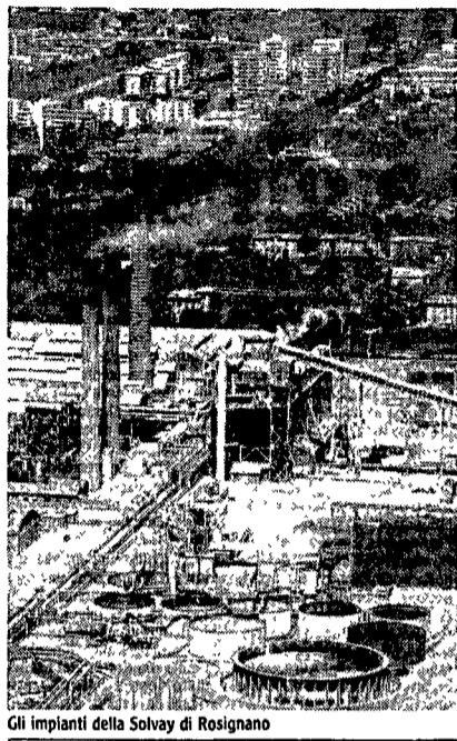
Gli impianti della Solvay di Rosignano
