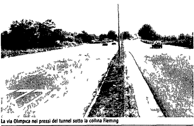
La via Olimpica nei pressi del tunnel sotto la collina Fleming
