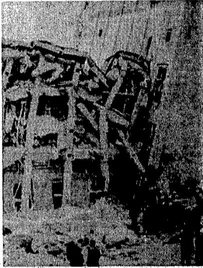
Un palazzo inclinato dalla furia del sisma
