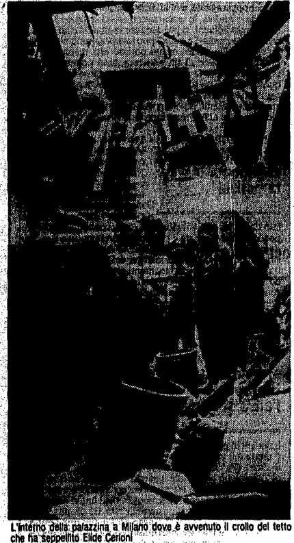
L'interno della palazzina a Milano dove è avvenuto il crollo del tetto che ha sepolto Elide Ceriani
