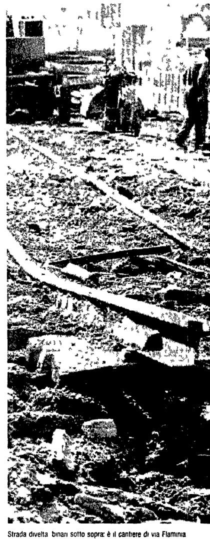
Strada divelta, binari sotto: sopra: è il cantiere di via Flaminia
