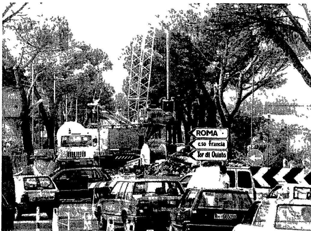
Auto in coda sulla via Flaminia, da quando sono iniziati i lavori per lo svincolo di via Due Ponti: il traffico è impazzito.
