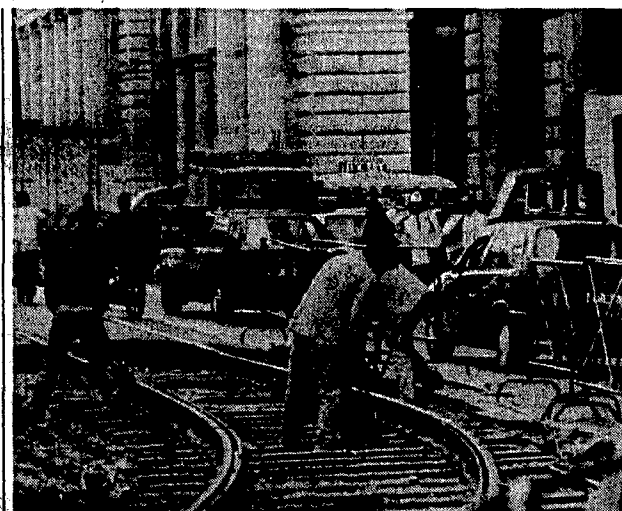
Piazza Vittorio Ingorgo perpetuo per i lavori
